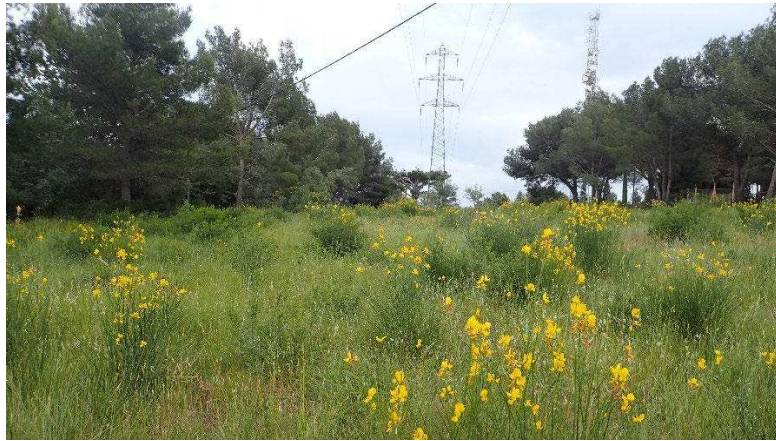
Ligne THT avec de part et d'autre une pinède, constituant un corridor de déplacement à chauves-souris
